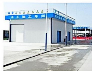
△封闭式木工加工车间
