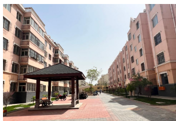
金花园社区A区西3#楼前改造后
