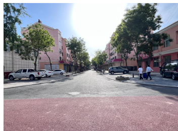
金花园社区A区广场西侧主路面改造后
