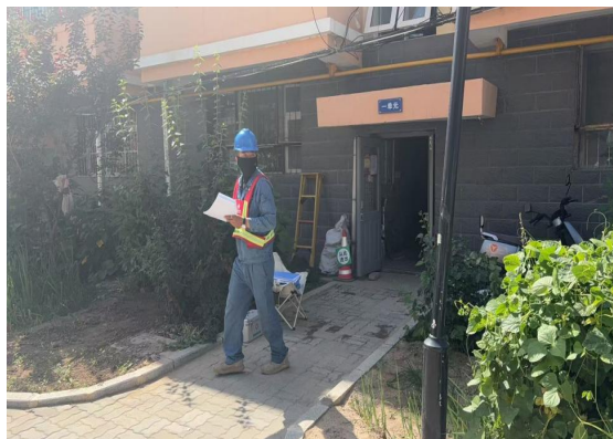
供电设施改造
