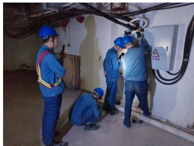
供电设施改造
