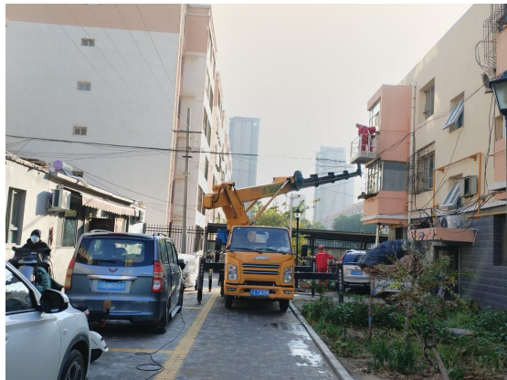
天然气改造施工
