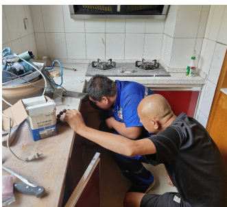
天然气管道更新
