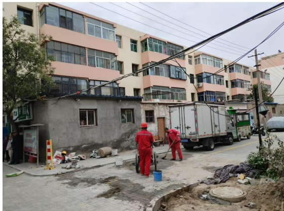
天然气公司施工
